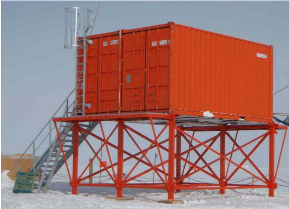
Nouveaux shelters : Shelter PHYSIQUE fini
