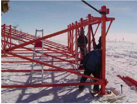
Nouveaux shelters : Assemblage des structures sur site
